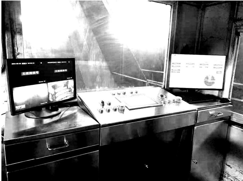
图4 组合电控柜现场安装情况
