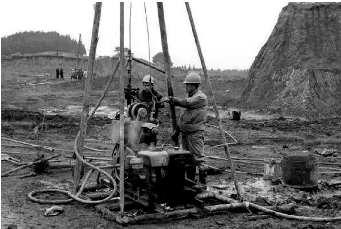
图1 岩土层钻探施工
