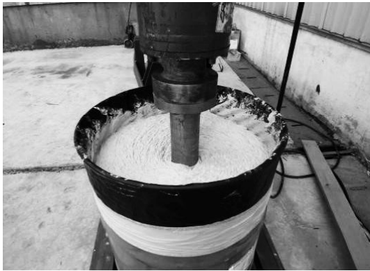
图 1 环保型水性阻尼涂料施工前搅拌
