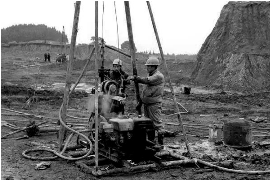
图1 岩土层钻探施工
