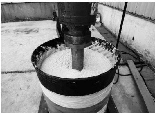
图 1 环保型水性阻尼涂料施工前搅拌
