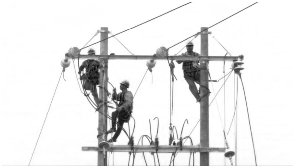
图1 某配电网建设现场图
