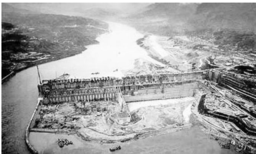
图1 某明渠导流工程现场
