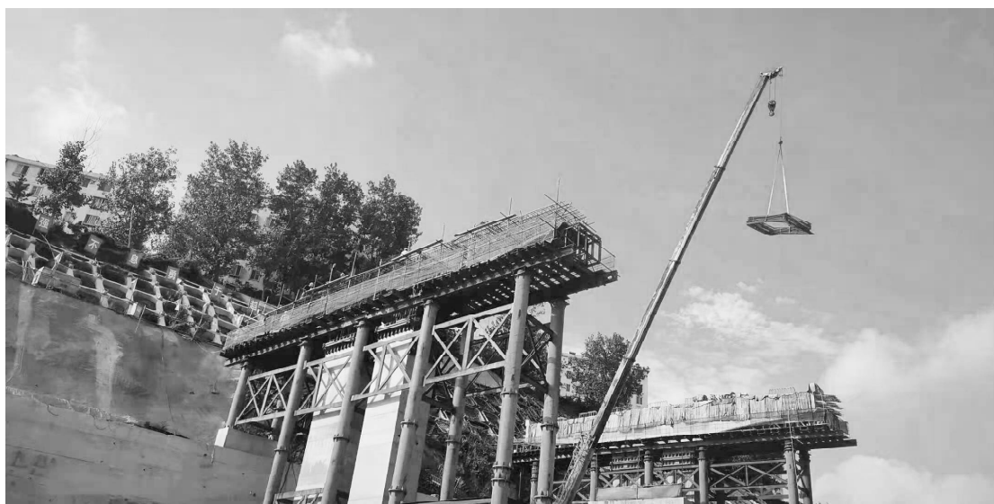
图1 钢支架现场安装
