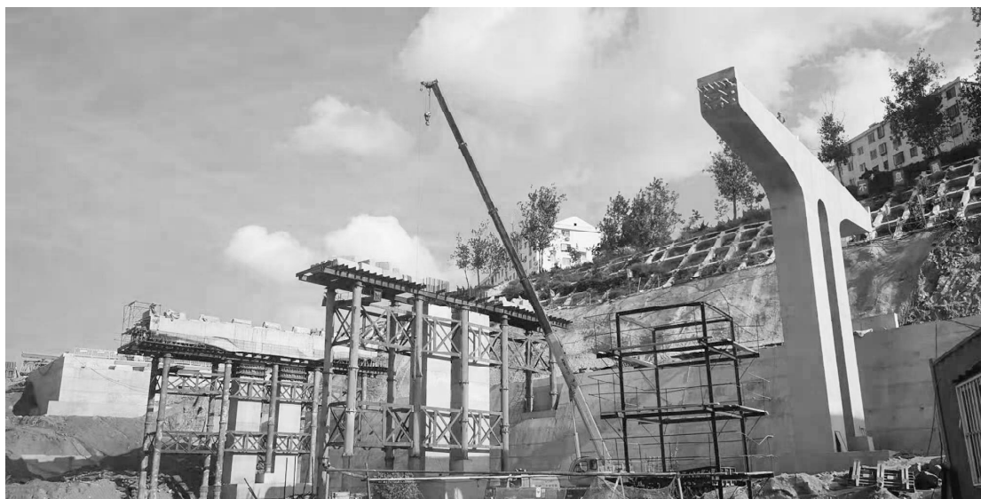
图2 盖梁浇筑成型
