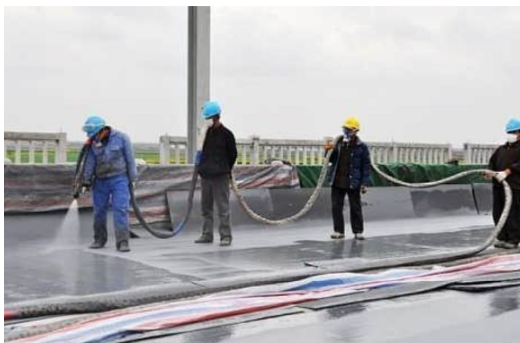
图1 混凝土养护
