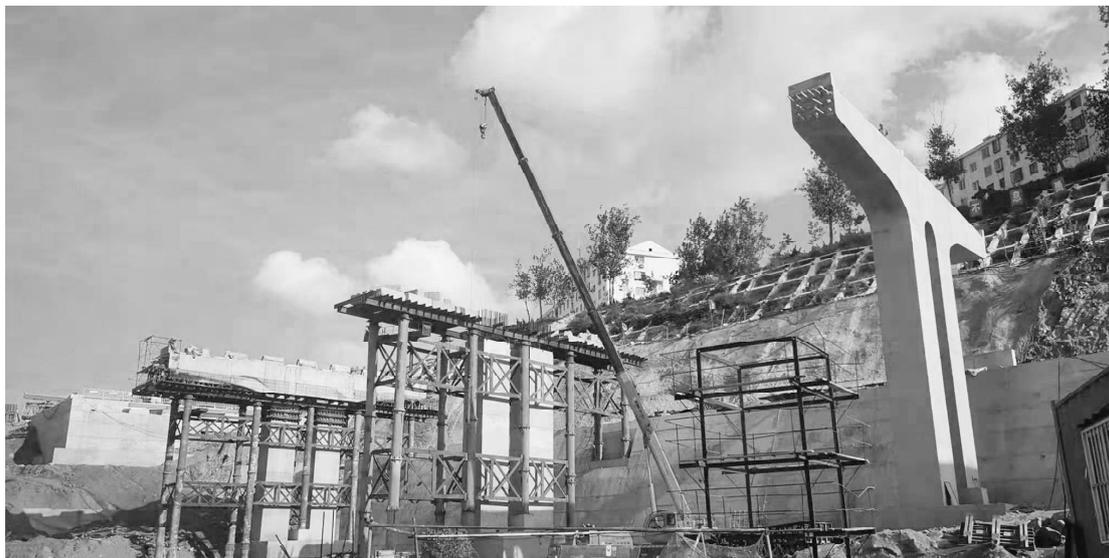
图2 盖梁浇筑成型
