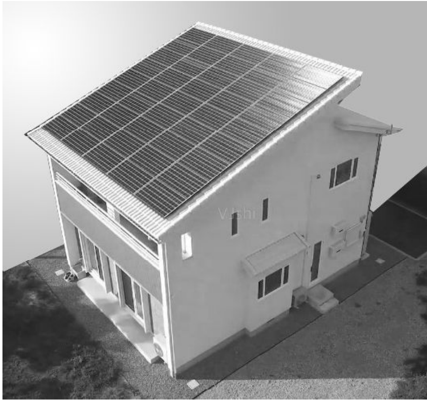
图1 房屋光伏系统
