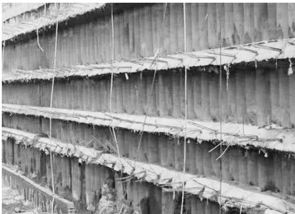
图 1 地下连续墙支护施工
