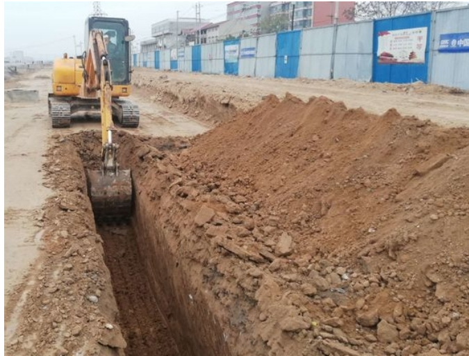
图 1 管道沟槽开挖
