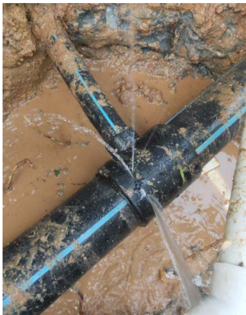
图2 管道漏水检测
