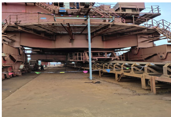
图 4 回转支撑更换平台
