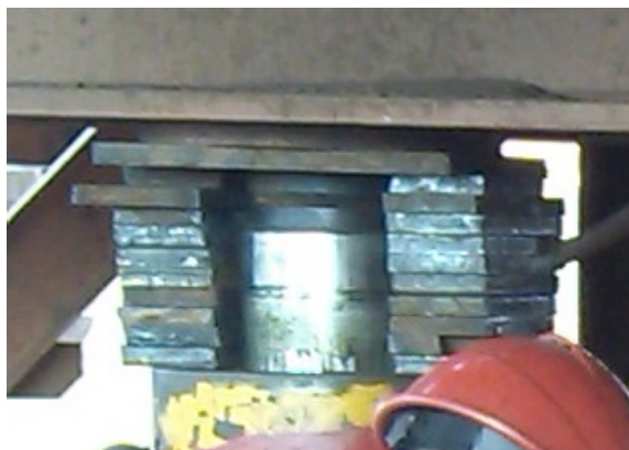
图 5 保险块安装示意图
