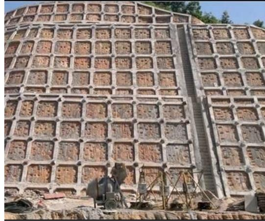
图2 排桩式锚杆挡墙支护图
