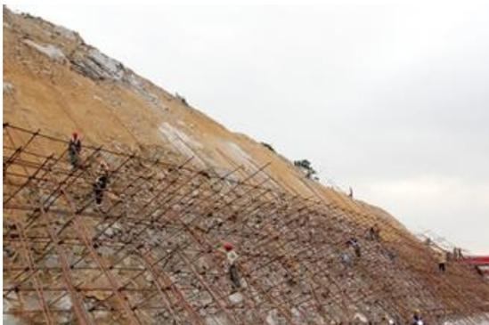
图1 格构式锚杆挡墙支护图
