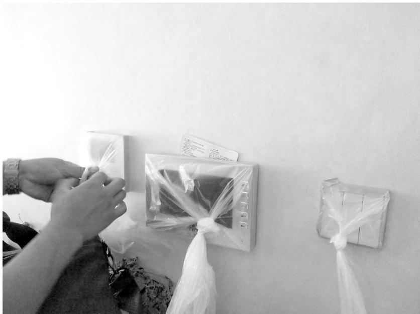
图1 开关面板保护处理
