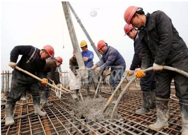
图1 混凝土浇筑
