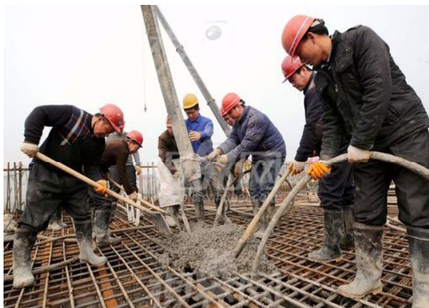
图1 混凝土浇筑
