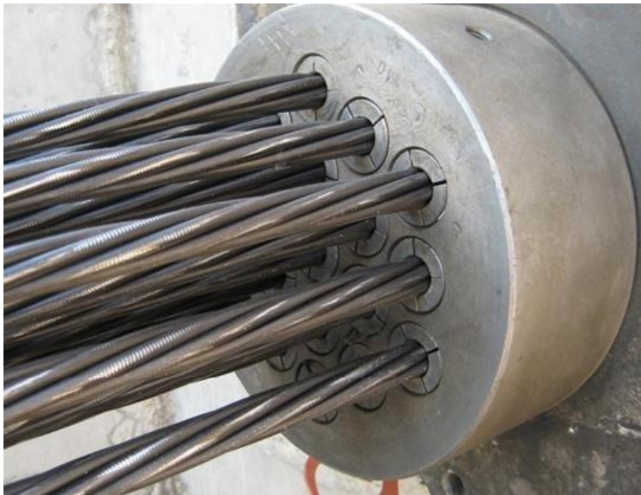
图 2 预应力固定端锚具
