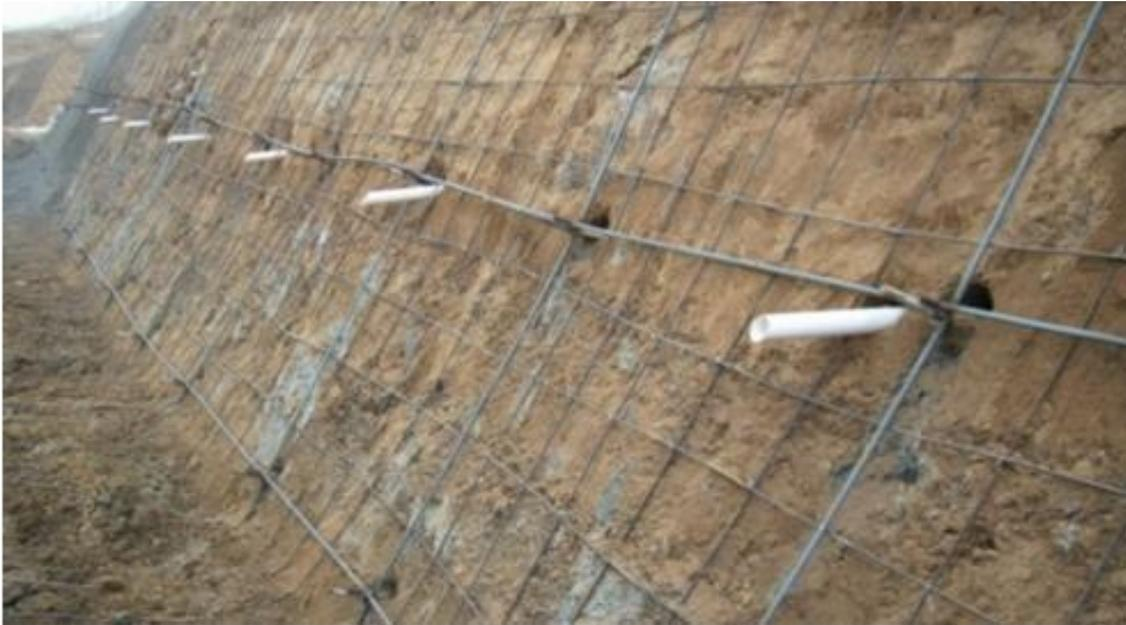
图1 土钉墙支护施工
