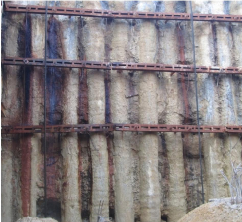
图2 桩锚支护施工
