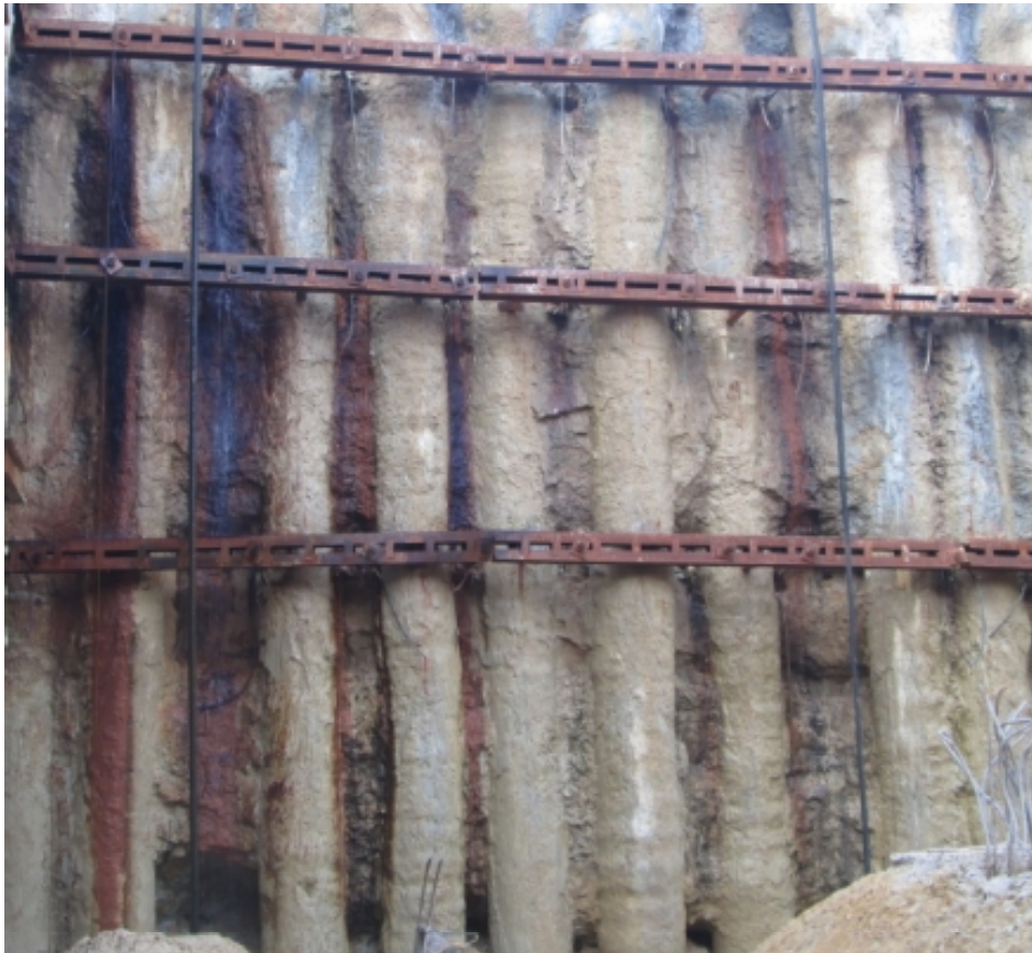
图2 桩锚支护施工
