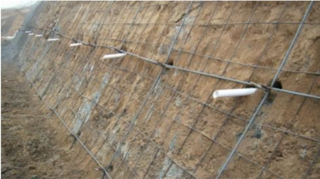
图1 土钉墙支护施工
