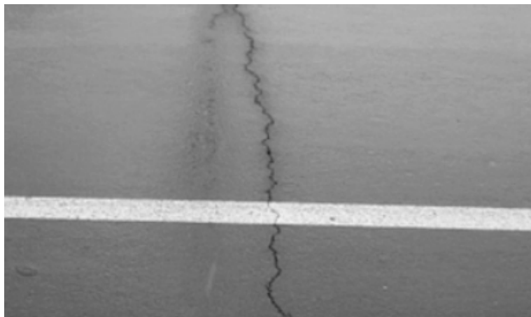
图1 横向裂缝
