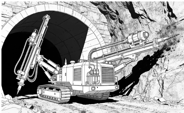
图 1 山区高速公路隧道开挖机械化作业图
