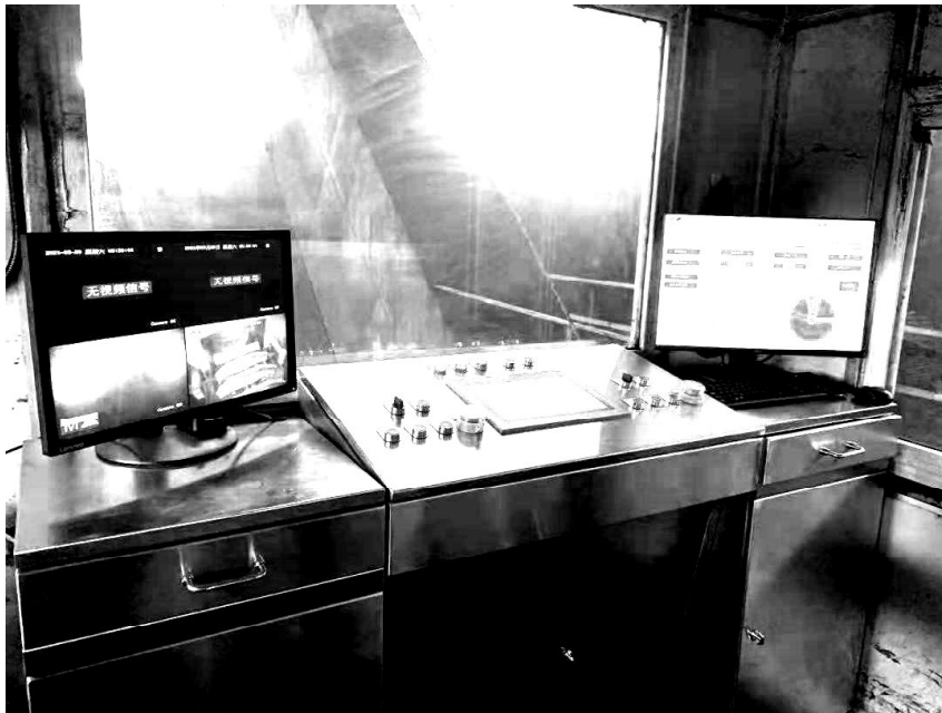
图4 组合电控柜现场安装情况
