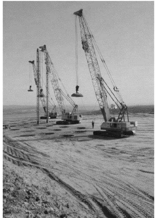
图2 粉喷桩施工现场
