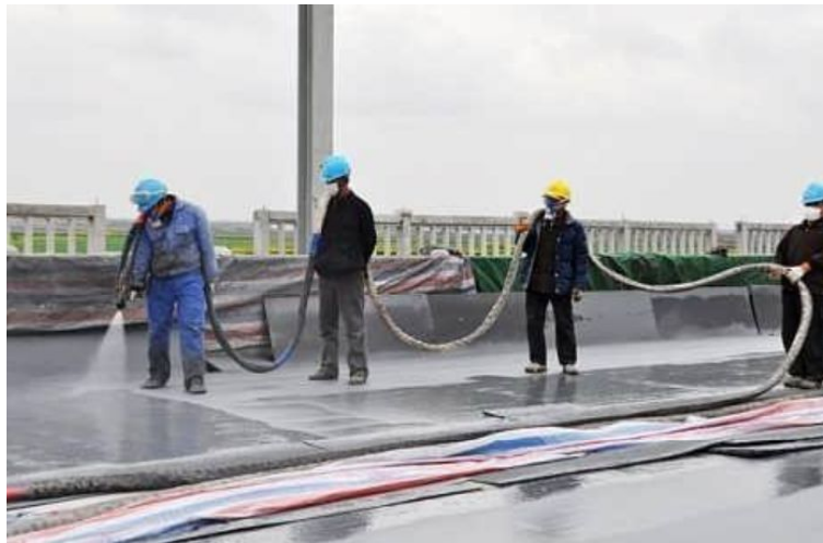
图1 混凝土养护
