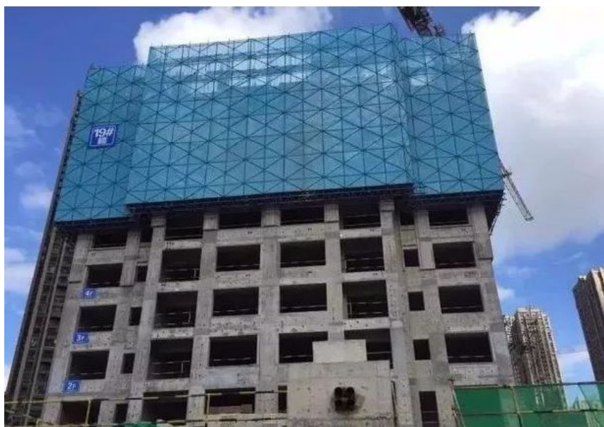
图1 某爬架施工现场
