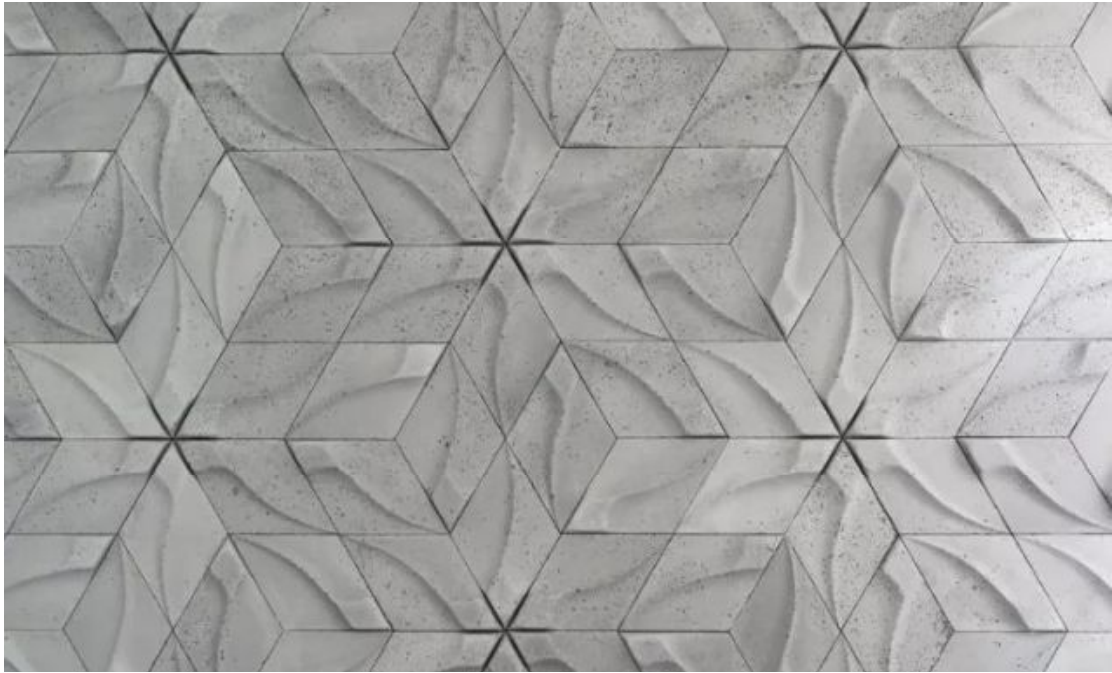
图1 清水混凝土墙面
