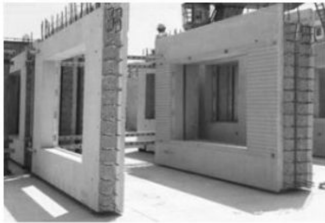
图1 模板安装现场
