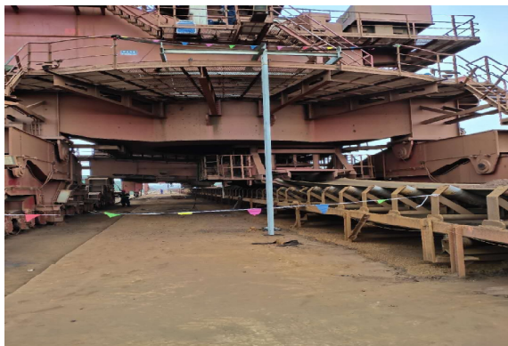
图4 回转支撑更换平台
