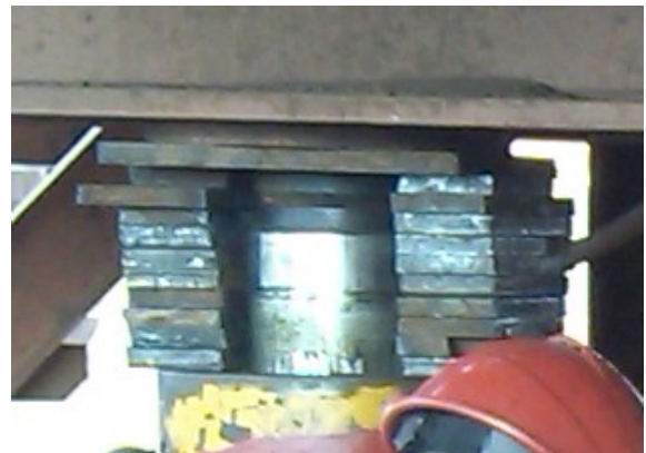
图5 保险块安装示意图
