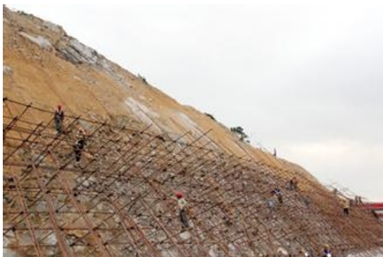
图1 格构式锚杆挡墙支护图
