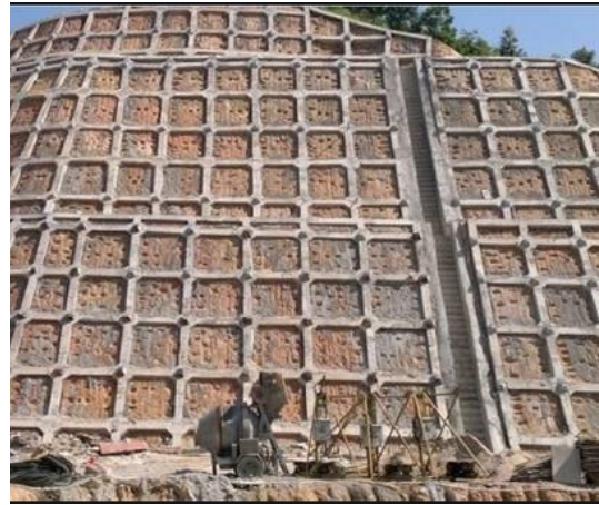
图2 排桩式锚杆挡墙支护图
