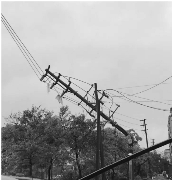
图1 电线杆倾斜
